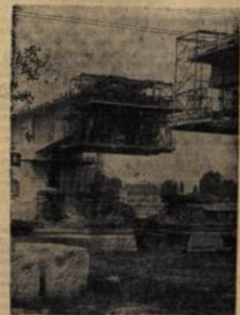
Neue Brücke wächst über den Rhein
