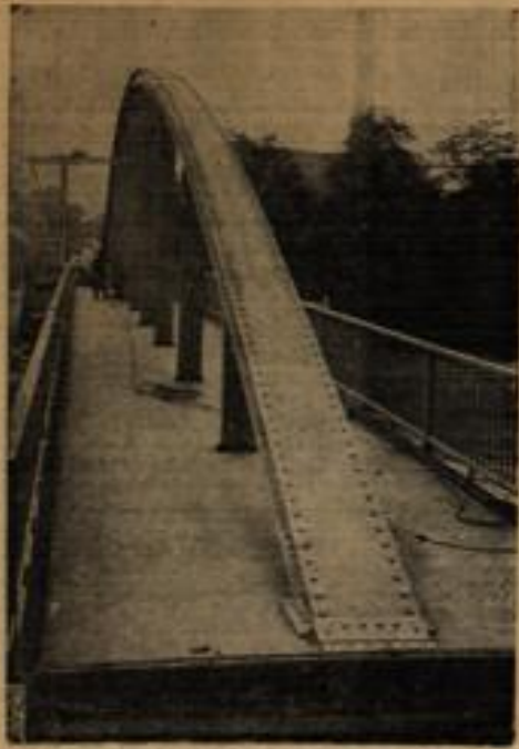
Die erste Mittelträgerbrücke der Welt mit einer Stützweite von 62 m wurde in Weisse-Eckel eingeschlossen. Anstatt der üblichen beiden Seitenstützen weist diese Konstruktion nur einen Mittelträger auf, zu dessen beiden Seiten sich die Fahrbahnen hinziehen. Die Fahrbahnen können später verbreitert werden.
