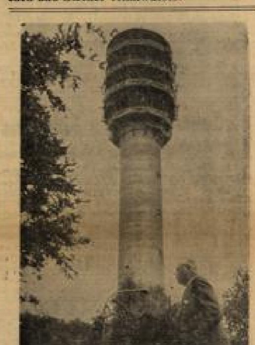
Richtkranz auf dem Fernmeldeturm In Egestorf (Hannover) wurde über dem zweiten Funkmeldeturm der Deutschen Bundespost der Richtkranz gesetzt...
