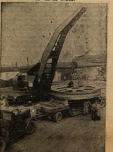
Erstmals wurde kürzlich eine Köpfscheibe im Gewicht von 30 t in einem Stück von der DB auf Schiene und Straße befördert. Bisher wurden derartige Schwerlasten in mehreren Teilstücken transportiert und am Bestimmungsort zusammengeschweißt.
