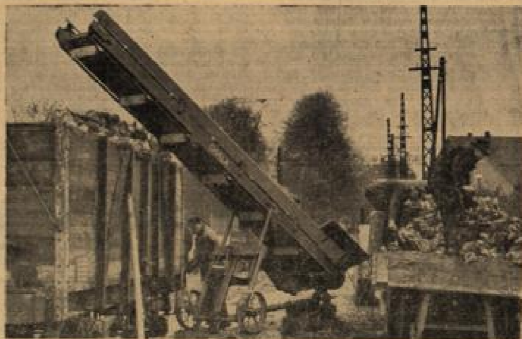
OGELA-STÜCKFÖRDERER BEIM VERLADEN VON RÜBEN. Der Einsatz des Ogela-Stückförderers bei Rübentransport bringt erhebliche Arbeitserleichterung mit sich. (Aufnahme DLP)
