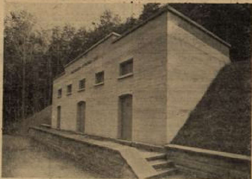
Der Eingang zur Schieberkammer und zum Rohrkeller. Rechts der Eingang zur Transformatorstation u. zur Pumpstation Waldkolonie. Die eigentlichen Wasserkammern, von denen wir eine im Bild rechts zeigen, befinden sich z. T. unterirdisch dahinter. Foto: E. O. Drücke
