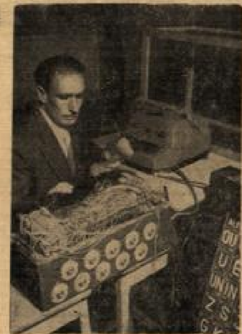
Eine phonographische Schreibmaschine wurde in Genf von dem Erfinder J. Dreyfuß-Graf erfunden (unser Bild). Der „Photograph“ soll das Sprechen in einen Text verwandeln, der durch eine elektrische Schreibmaschine getippt wird. Ein Gehirn aus elektrodynamischen Relais vermittelt die beim Sprechen erzeugten phonographischen Impulse. Einige Dutzend alphabetische Elemente betätigen von diesem Gehirn aus die elektrische Schreibmaschine. Durch diese Erfindung kann man nun in Zukunft Briefe sprechend schreiben.
