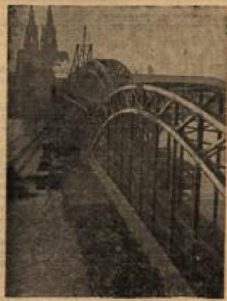
Die Hohenzollernbrücke in Köln die meistbenutzte Eisenbahnbrücke Deutschlands, wird am Sonntag einen neuen, 180 Meter langen Mittelbogen erhalten. Die Brücke wird deshalb 27 Stunden für den Verkehr gesperrt werden, und die 600 Züge, die täglich über die Brücke fahren, werden umgeleitet.
