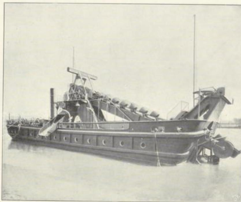
Abb. 12. Dampfbagger Roland, erbaut 1884, verstärkt 1894.
