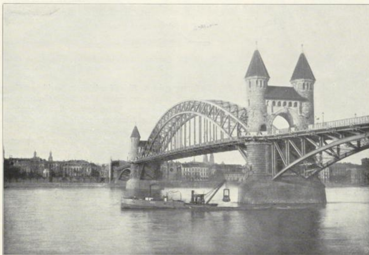
Abb. 40. Die Rheinbrücke bei Bonn, erbaut 1896 bis 1898.
