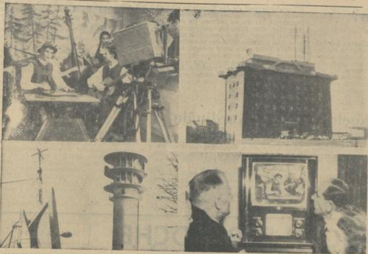
Vom Sender zum Empfänger. Acht Türme bilden die drahtlose Fernsehbrücke, auf der das Gemeinschaftsprogramm des NWDR-Fernsehens von Turm zu Turm weitergereicht wird. Im Studio wird die Spüfung von der Fernsehkamera aufgenommen (links oben) und über die Sendeantennen ausgestrahlt. Auf dem Haus rechts oben sind die Sendeantennen zu sehen. Das Bild unten Mitte zeigt einen Relaissturm der Sendebrücke. Links daneben: ein UKW-Strahler des Turmes. So gelangt das Bild schließlich auf den Schirm des Empfangsgerätes (rechts unten).
