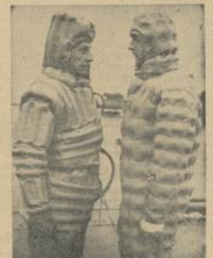
Gut verpackt können diese beiden britischen Marinesoldaten einem Aufenthalt im Wasser gelassen entgegensehen. Die neuen Schutzanzüge halten ihr Gesicht auch bei einer Bewußtlosigkeit über Wasser und schützen sie vor Kälte. ap-Foto
