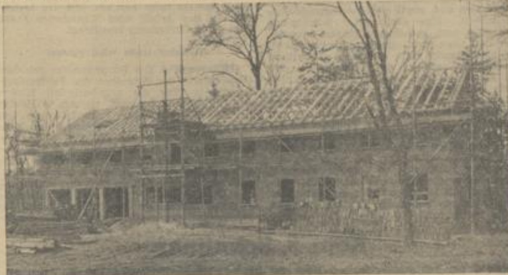
Die Jugendherberge im Robbau fertiggestellt
