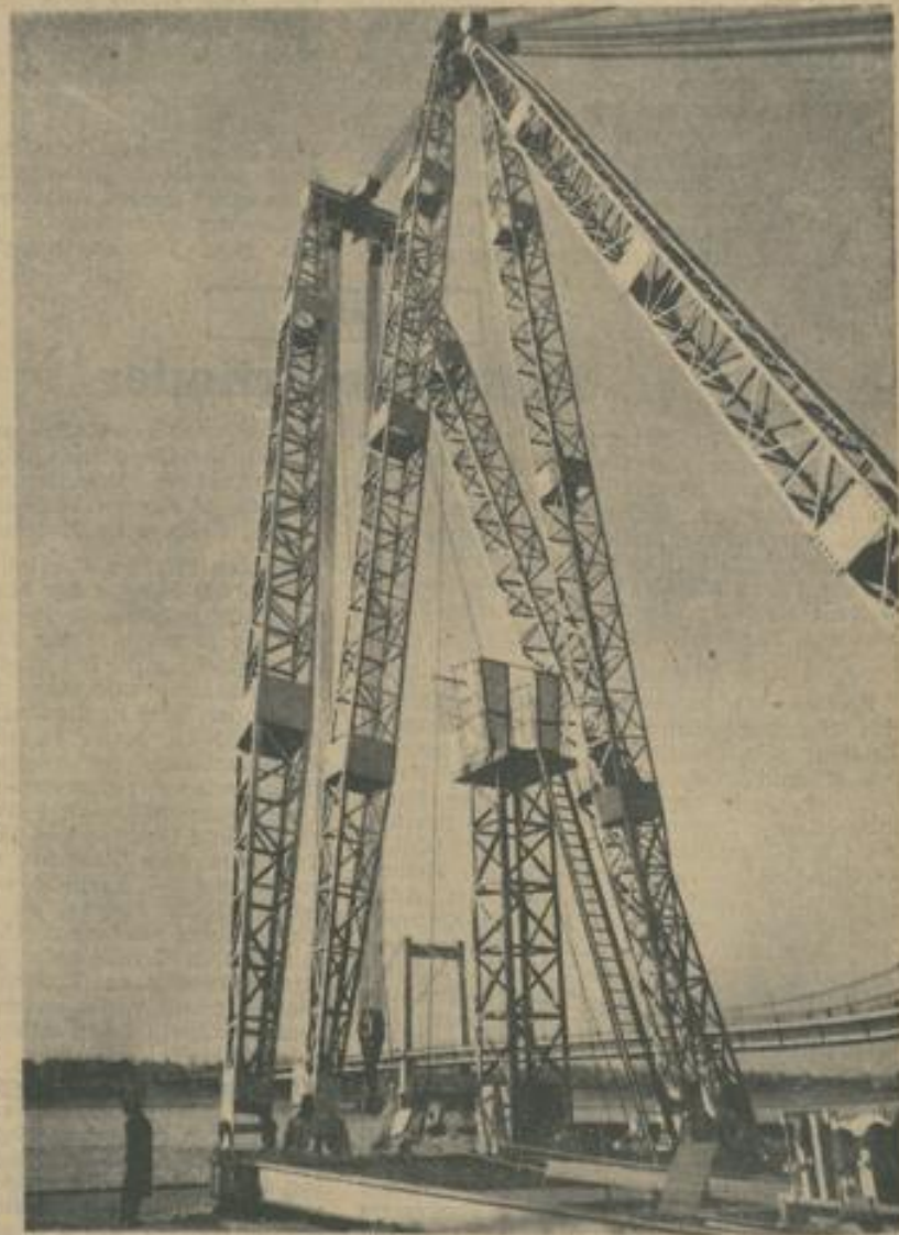
Dieser 70 t tragende Kran wurde am Rheinkai in Köln-Mülheim montiert, ist 30 m hoch und wird im März in Betrieb genommen.
