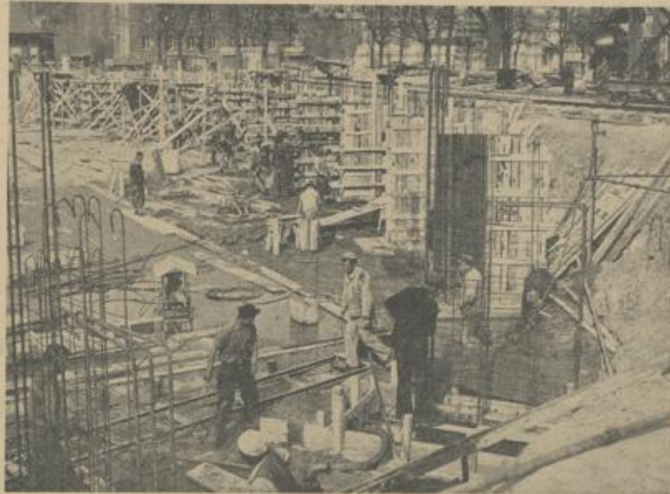
An der Baustelle „Schwarzwaldhalle“ wird mit Bienenfließ gearbeitet. Die Ausgrabungsarbeiten sind beendet, und die eigentlichen Bauarbeiten beginnen. Foto (4) Weiß
