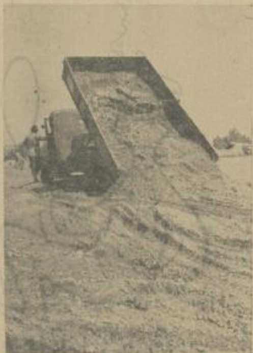
Kubikmeter um Kubikmeter wird aufgeschüttet beim Bau des Groß-Dampf-Kraftwerks am Rheinhafen
