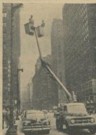
Vielseitig verwendbar ist dieser neue Fahrstuhl, der von den Gas- und Elektrizitätswerken Chikagos vorgeführt wird. Der schwenkbare Arm kann in einem Umkreis von zehn Metern bei einer maximalen Höhe von 14 Metern ausgefahren werden. ap-Foto
