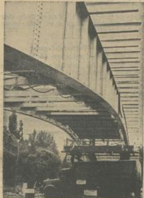
Erste Aluminium-Brücke in Deutschland
