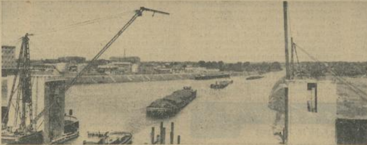
Das größte Stauor der Welt entsteht. In Duisburg ist mit dem Bau des größten Stauores der Welt begonnen worden, dessen Wand zehn Meter hoch ist und dessen Breite sich über 42 Meter erstreckt. Das Tor soll verhindern, daß bei Hochwasser der Ruhr und des Rheins die Fluten in den Rhein-Herne-Kanal fließen und den Schiffsverkehr lahmlegen. Unser Bild zeigt die beiden im Bau befindlichen Türme und die Breite des Tores.
