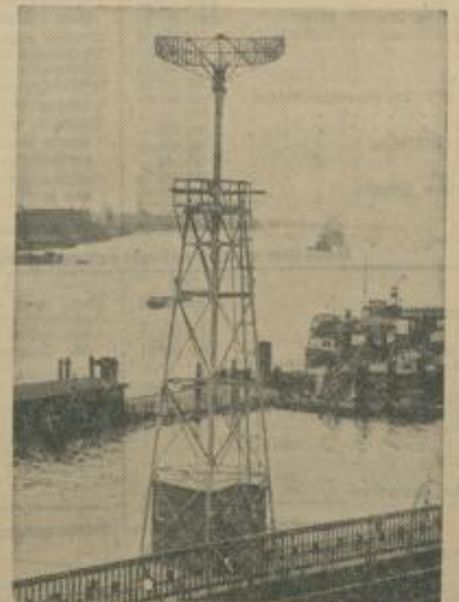
Im Hamburger Hafen werden gegenwärtig mit einem transportablen Radar-Turm Versuche angestellt, durch die die Aufstellungspunkte für geplante ortsfeste Radartürme ermittelt werden sollen. Über dieses projektierte Radarsystem soll mit den Lotsen der Schiffe bei schlechter Sicht Verbindung aufgenommen werden. Durch diese Anlage verspricht man sich eine Steigerung der Fahrtsicherheit. Unser Bild zeigt den „wandernden“ Radarturm in der Nähe der St.-Pauli-Landungsbrücken.
