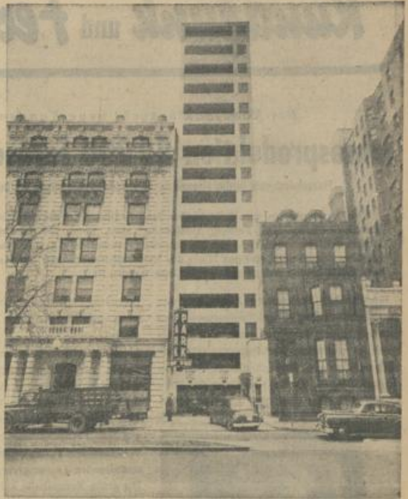
Außenansicht der voll-automatischen Park-O-Mat-Garage in Washington. Zwei Aufzüge im Innern bedienen alle 18 Stockwerke (einschließlich des Erdgeschosses). Foto: A. D.
