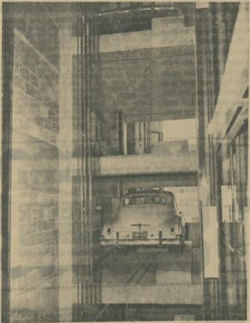
Blick in eine Abstellbox hoch über der Straße. Mit der gleichen Schiebevorrichtung, die den Wagen in den Aufzug geschoben hat, wird das Fahrzeug auch zu seinem Parkplatz gebracht. Bei Wiederaushändigung wiederholt sich derselbe Vorgang in umgekehrter Richtung.
