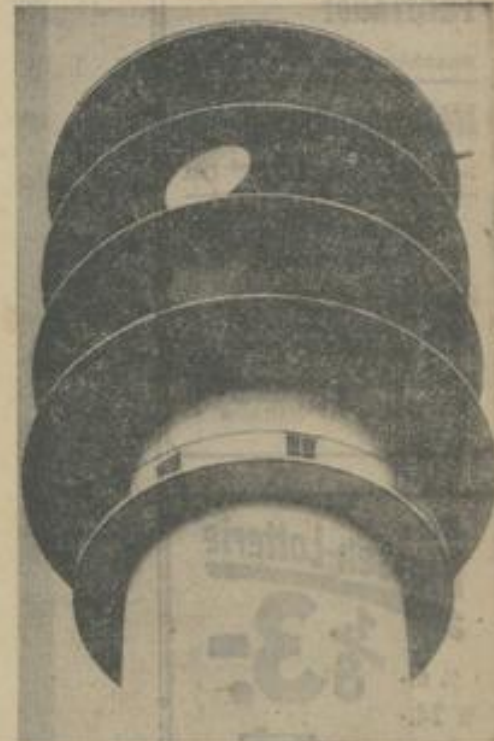
U-Turm der Dezimeterstrecke
