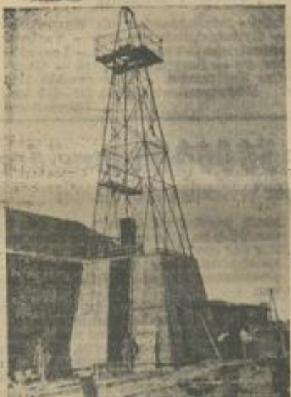
Die Bohrtürme des Kohlenbergwerkes recken sich bereits innerhalb des Ortes gen Himmel. Bevor die Bagger kommen, wird durch Bohrungen Lage und Ergiebigkeit der Kohle ermittelt.
