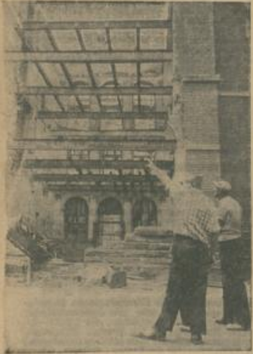
Hier befand sich einmal die Turnhalle der Karl-Wilhelm-Schule. Jetzt wird eine große Eintrittshalle daraus.
