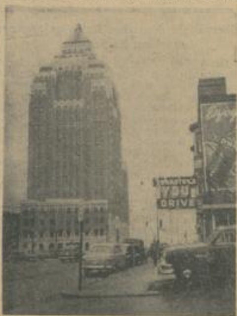
Marine-Building, eines der Geschäfts- und Bürohochhäuser in Vancouver
