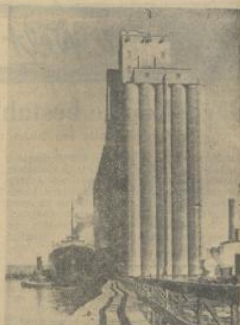
Getreidespeicher im Hafen von Superior
