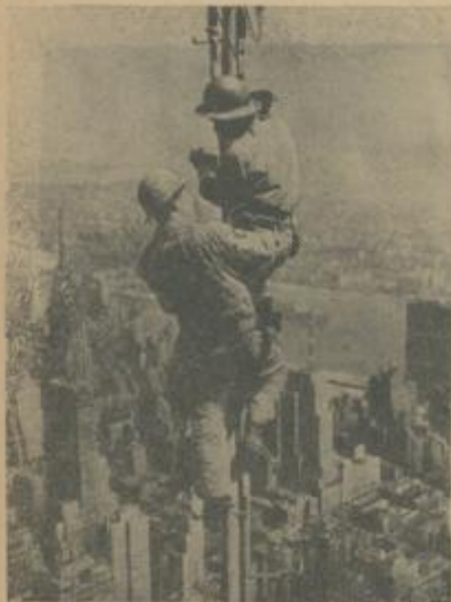
FAST 400 METER HOCH ist das Empire State Building. Es umfaßt 102 Stockwerke. — Hier wird eine Montage an der Spitze des Gebäudes durchgeführt.
