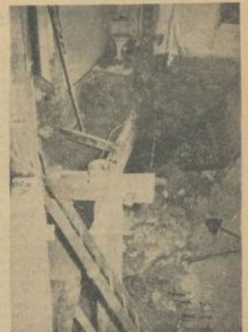
Mit der Wohnung in den Kanal gestürzt
