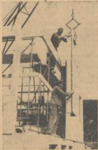
Arbeiter beim Montieren der Fertigbauteile Aufsicht: Darr-Firmenich
