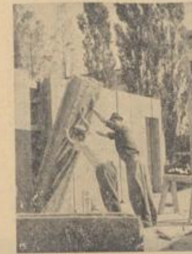
Ein Stück Wand wird eingesetzt. Foto: Dürr-Firmenich
