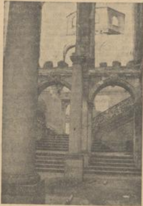
Von dem kühlen Atem der „Grünen Lunge“ unserer Stadt unmittelbar durchweht, ist die Ruine des Karlsruher Schlosses. Dort ist nun aller Schutt entfernt, und die Kellerdecken sind, um einen weiteren Verfall zu verhüten, mit Zementplattgestrichen. Ob und wann das Karlsruher Schloss wieder aufgebaut werden kann? Foto: G. Künzel
