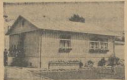
Das neue, wohnliche Stahlhaus
