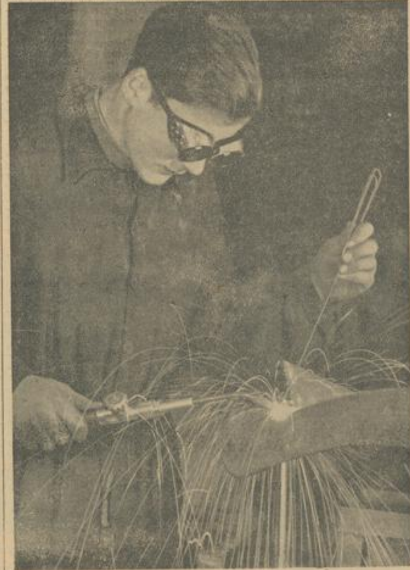
In der Antowerkstatt: Beim Schweißen
