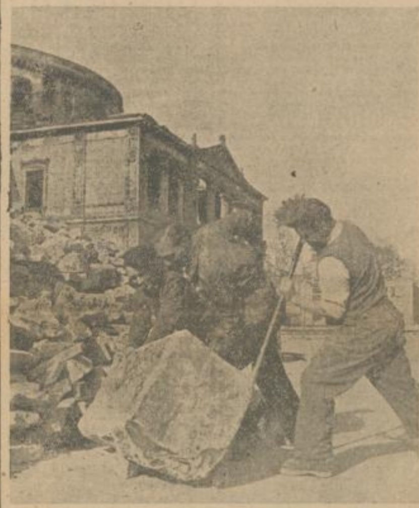
BEI DEN AUFRÄUMUNGSARBEITEN
