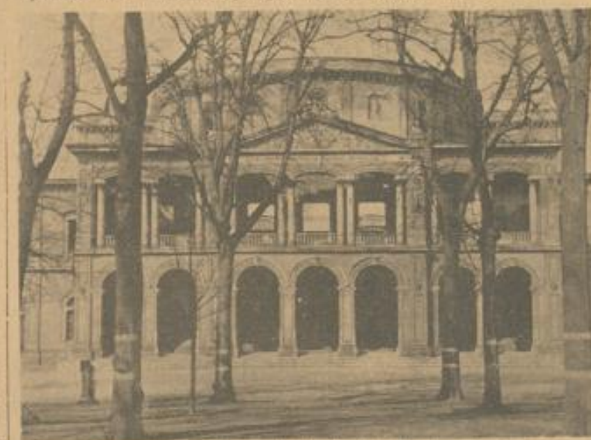
Das ausgebaute Theatergebäude des Badischen Staatstheaters.
