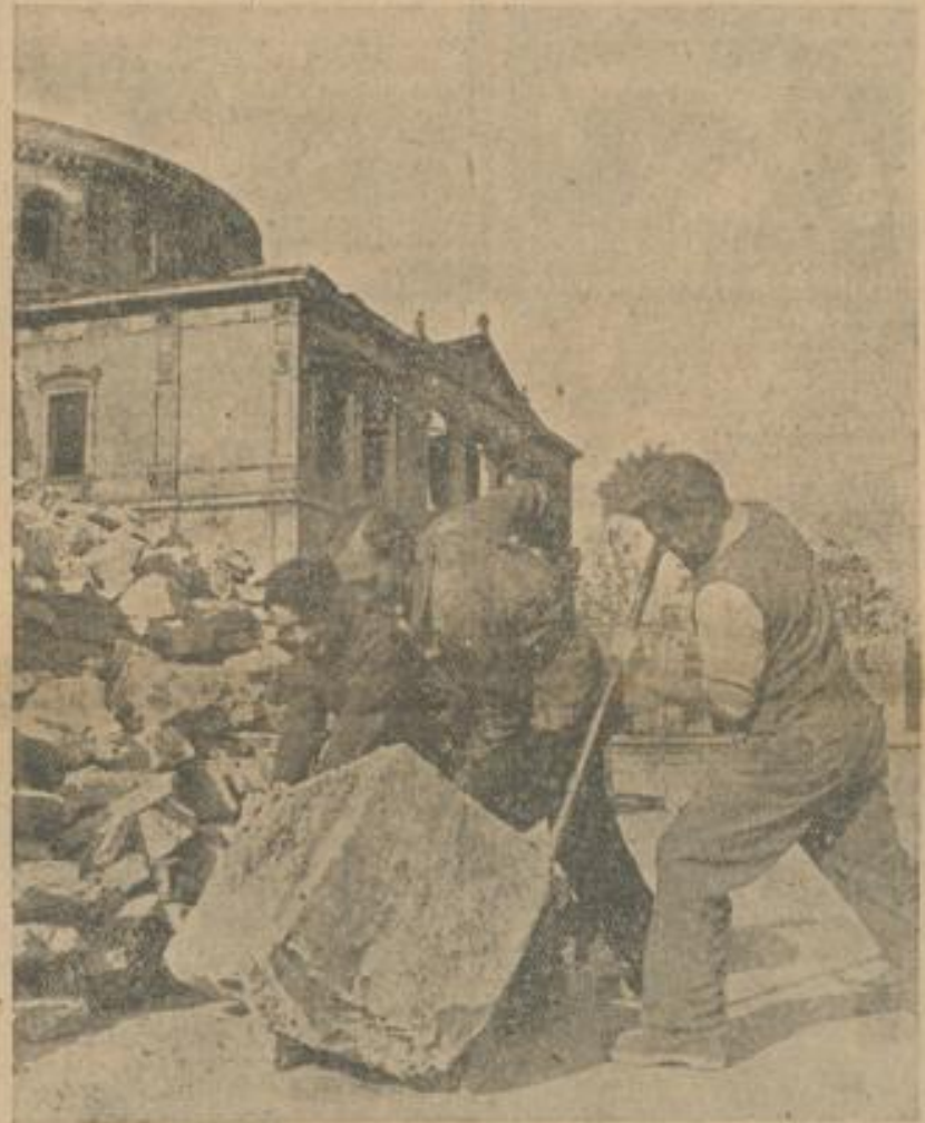
BEI DEN AUFRÄUMUNGSARBEITEN Foto: Wörner.
