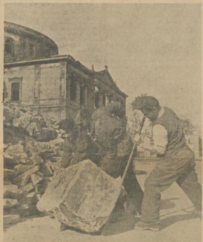
BEI DEN AUFRÄUMUNGSARBEITEN
