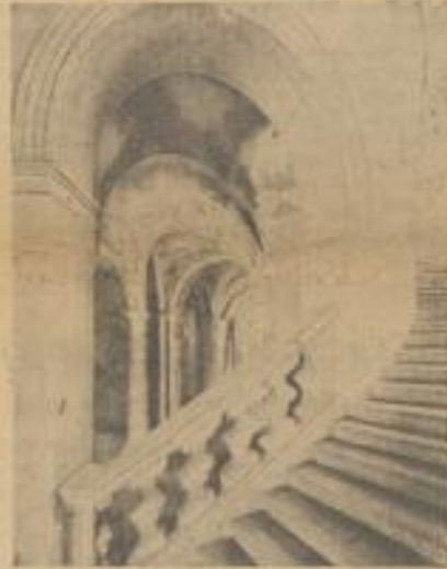
Blick auf die Treppe und den Grottenaal
