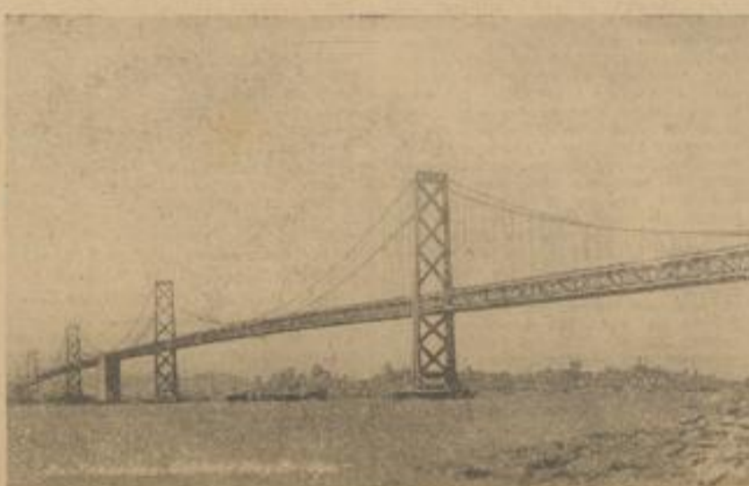
Die San Francisco-Oakland-Brücke, deren Gesamtlänge 13 km beträgt. Im Mittel- feld (im Bild links) ist mehr Zement enthalten, als in der Stadt San Francisco.
