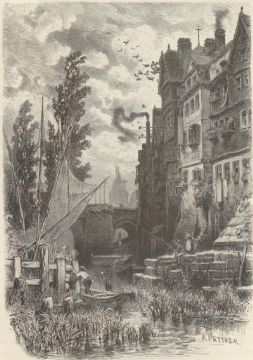
An der alten Malerbrücke in Badenfels.
