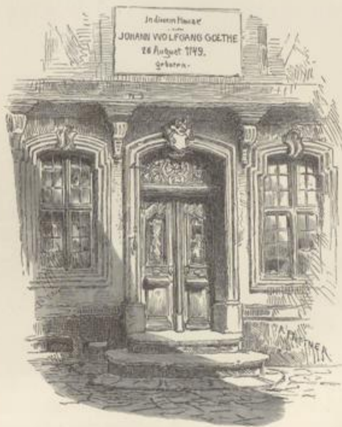
Goetheshaus in Frankfurt.
