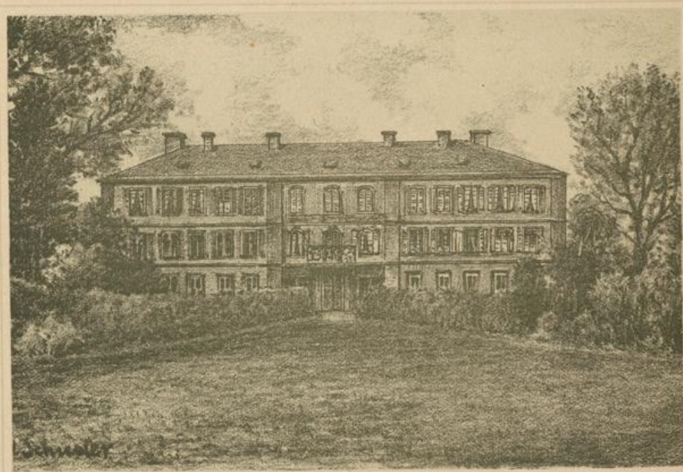
Das Schloß in Messelhausen.
