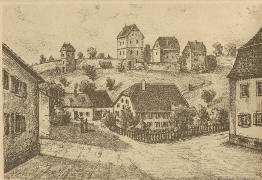
Die Reste des Schloßes zu Waldangeloch vor dem Abbruch um 1900.
