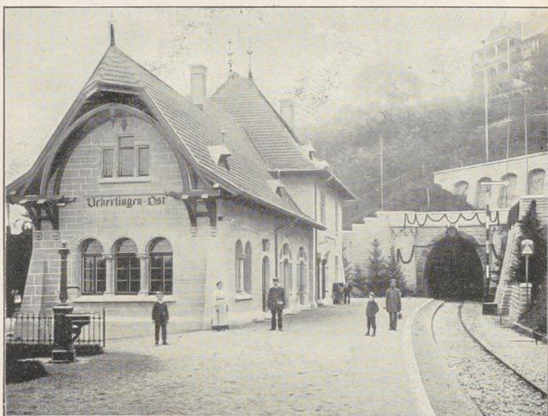
Tunnel bei Überlingen, Ostportal.
