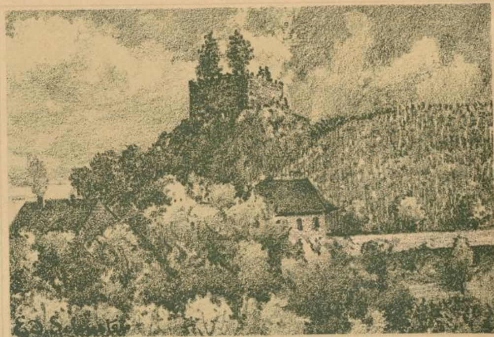
Der Eckartsberg in Breisach (ehem. Kastell).
