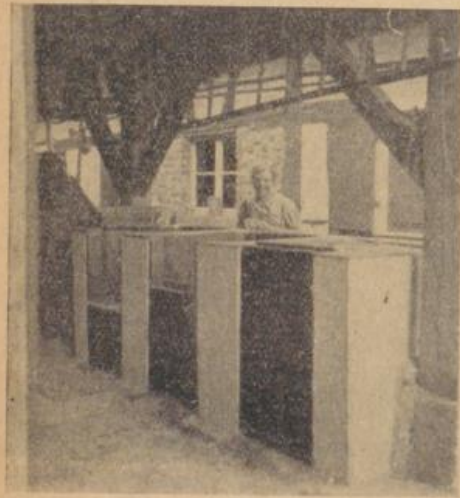
3 Kammer-Kartoffelsilo unter ein Vordach gebaut
