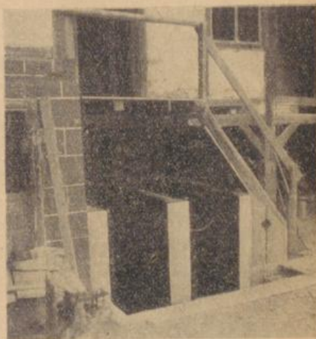
4 Kammer-Kartoffelsilo (Quadratverband) unter eine Treppe gebaut
