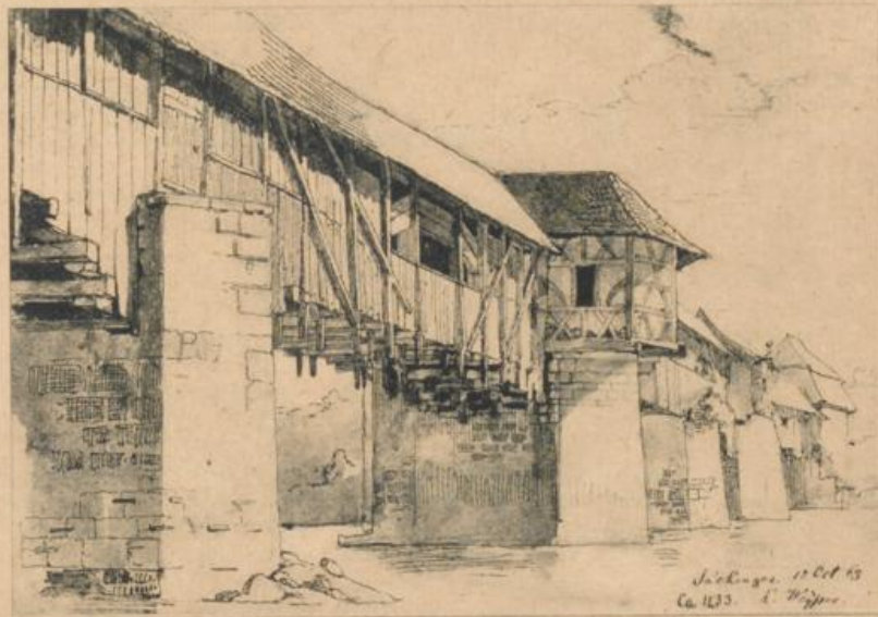
Die Holzbrücke bei Säckingen im Jahre 1863. Nach einer Handzeichnung von K. Weysser, im Besitze des Bad. Landesdenkmalamtes
