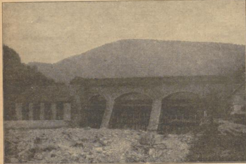
Wehr bei Forbach
