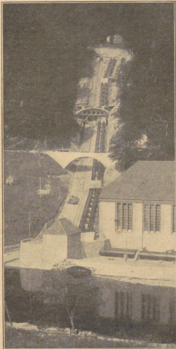
Kraftshaus mit Rohrleitung, Seilbahn und Wasserjoch.
