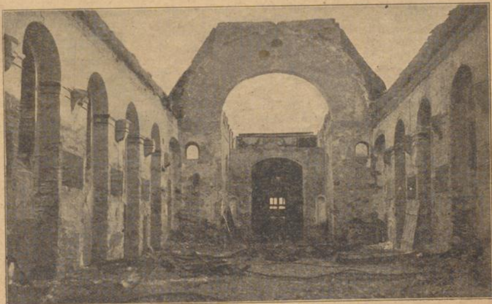
Die Wallfahrtskirche nach dem Brande.
