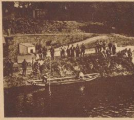
Brückeneinsturz in Koblenz bei der Befreiungsfeier.
