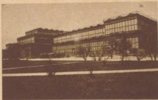
Der Glaspalast in München, durch Brand am 6. Juni 1931 zerstört.
