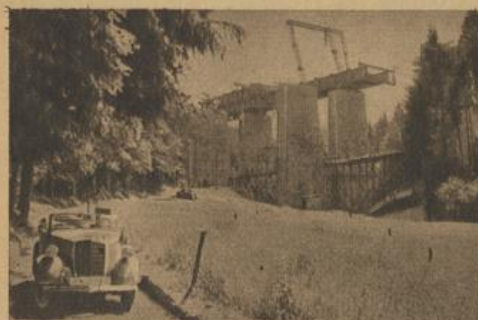
Ein Bild von dem gewaltigen Werk der Reichsautobahnen Talübergang bei Rohreut
