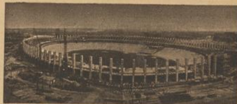
Das Olympia-Stadion im Bau.
