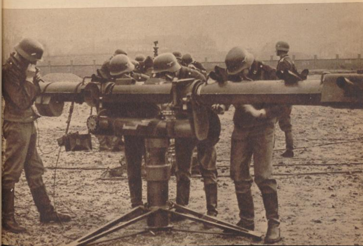
Das Kommandogerät der schweren Flak-Batterie, mit dem feindliche Flugzeuge anvisiert werden
