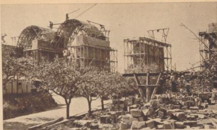
Die Talbrücke Pforzheim 14 mächtige Wogen führen die Autobahn über das Tal bei Dspringen in der Nähe Pforzheims. Die Brücke wird wohl im Jahre 1940 fertig werden
