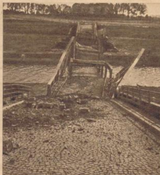
Gesprenge Brücke am Albertkanal
